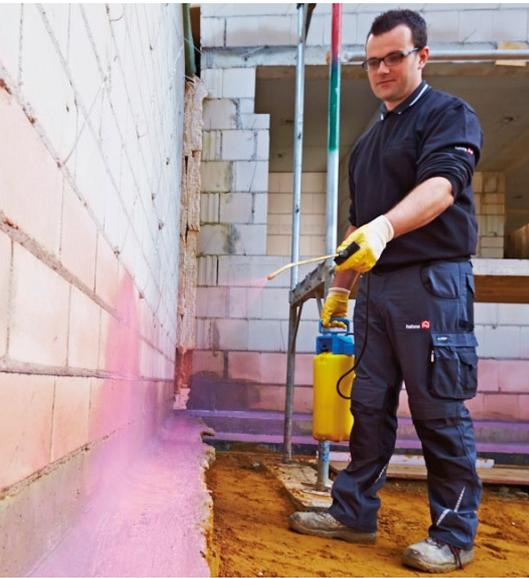
Die Außenflächen von Bauteilen brauchen einen beständigen und nahtlosen Schutz gegenüber Feuchte und eindringendem Wasser. Die Abdichtungsnorm DIN 18195 regelt hier weitgehend alle Anforderungen im Bereich der Einsatz- und Anwendungsmöglichkeiten der Abdichtungen.
