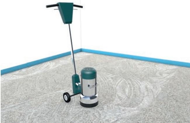
1.2 Untergrund zur Beschichtung vorbereiten mittels Diamantschleifer oder Kugelstrahlgerät
