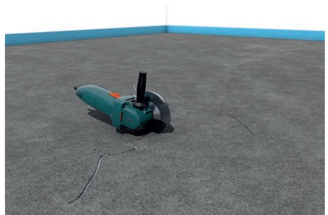
1.3 Vorhandene Risse auf min. 5 mm in der Breite und Tiefe weiten und im Abstand von 15 - 20 cm Längsschnitte positionieren
