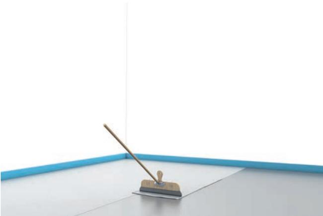
3.1.1. Aufbringen der Bodenverlaufsmasse mittels Zahnrakel
