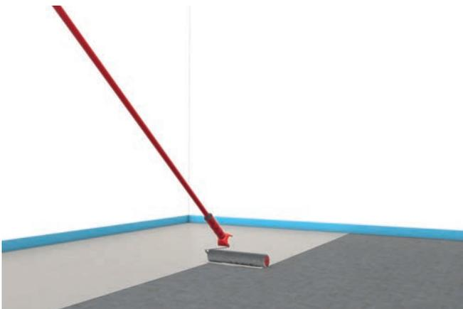
2.1 Grundieren der Bodenfläche mittels geeignetem Werkzeug (z. B. Kurzflorwalze oder Gummischieber)
