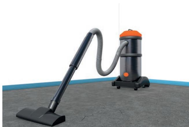
1.5 Entfernen von Staub und anderen Verunreinigungen zur Herstellung eines tragfähigen Untergrundes
