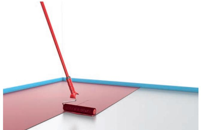
3.1.2. Aufbringen der Rollbeschichtung mittels Kurzflorwalze
