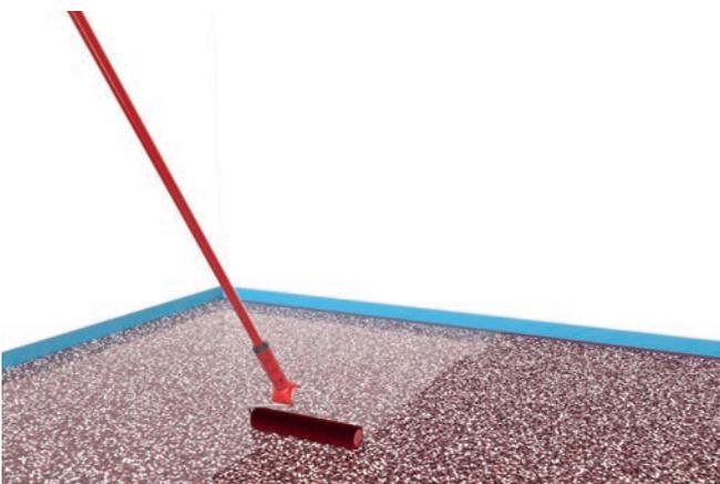
3.3.1. Aufbringen der Versiegelung entsprechend dem gewählten Beschichtungsaufbau
